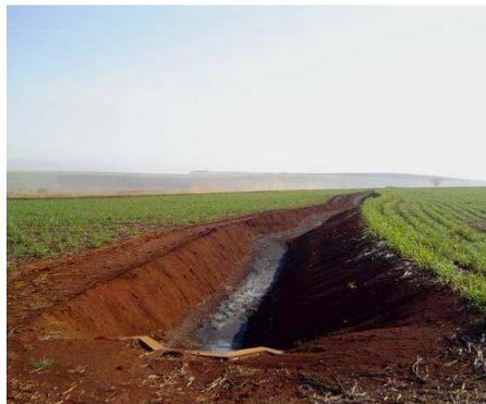
**Figura 4.** Canales de drenajes revestido y desnudo de distribución de vinazas
